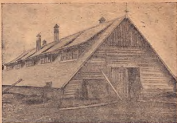
Свиносовхоз «Пятилетка», Кунцевского района, Московск. обл. В ноябре закончилось строительство нового свиноводческого типа
