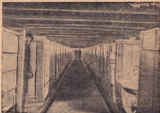
СТКФ «Вперед», Бобровский район, ЦЧО Недавно закончилось строительство свинарника на 60 голов при СТКФ «Вперед». Его внутренний вид
